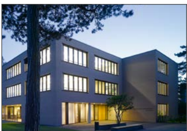
GEBÄUDE A Paulusweg 6
